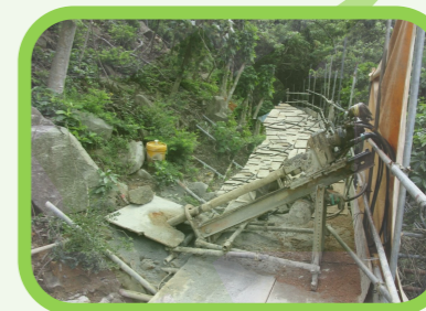
在連德道及曉光街的斜坡上安裝泥釘，以鞏固山坡。(左圖為泥釘裝嵌機)
